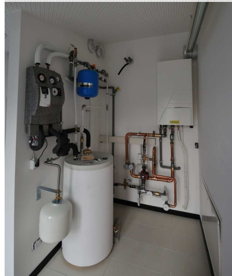
Pompa di calore aria-acqua (7 kW per riscaldamento, 6.1 kW per il raffrescamento). Solare termico (3 collettori solari, 160 l serbatoio di accumulo)
