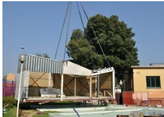
VeluxLAB: inizio del cantiere
