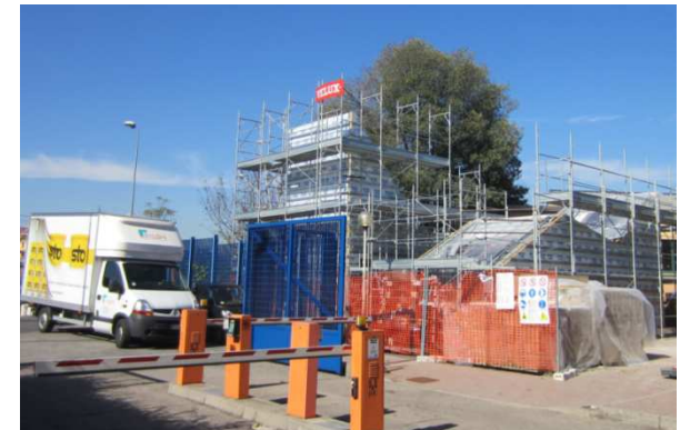
4 mesi di lavoro: Più di 20.000 viti, 100 m 3 di isolamento
